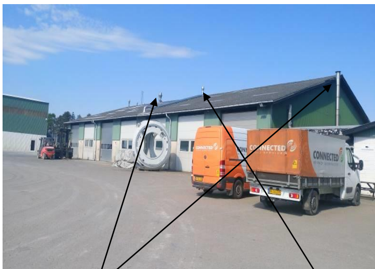
Billede nr. 2: Afkast 1 (Punktudsugning - slibning), Afkast 14 (ny stor vaskemaskine), Afkast 10 (anvendes ikke)
