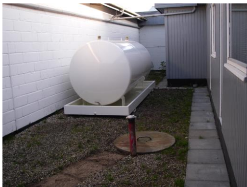
Billede nr. 11: Oiletank nr. 4. Tanken er nu overdækket.
