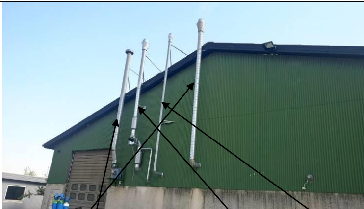
Billede nr. 1: Afkast 2 (punktudsug), Afkast 3 (boltvasker), Afkast 4 (Anvendes ikke), Afkast 5 (vaskemaskine)
