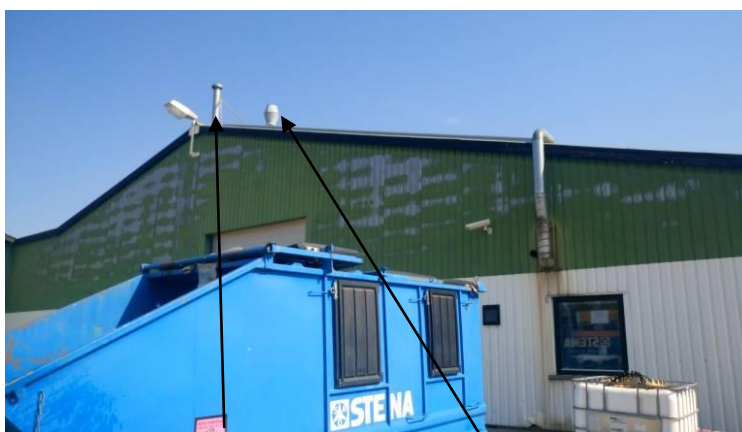
Billede nr. 3: Afkast 7 (vaskemaskine), Afkast 8 (højtryksudsug (kW + MW-værksted)
