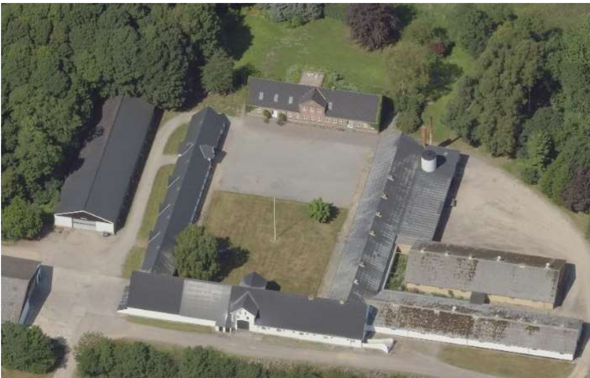
Figur 4: Den opførte silo stikker gennem taget tæt ved stald 1+2.
