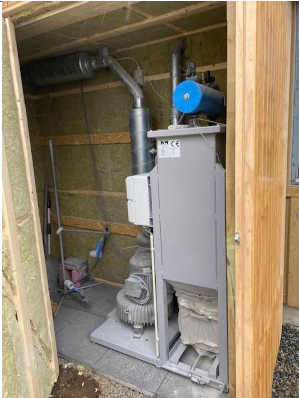
Billede 1. Ny pumpeudsugning i skur
