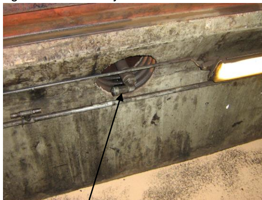
Billede nr. 13 - Studs i smøregrav, hvorfra spildolie tidligere blev pumpet til spildolietank (2013).
