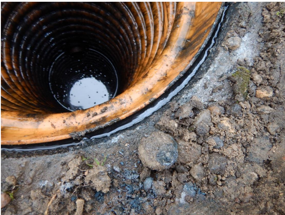
2. Sortfarvet vand rundt om røret til prøvetagningsbrønd.
