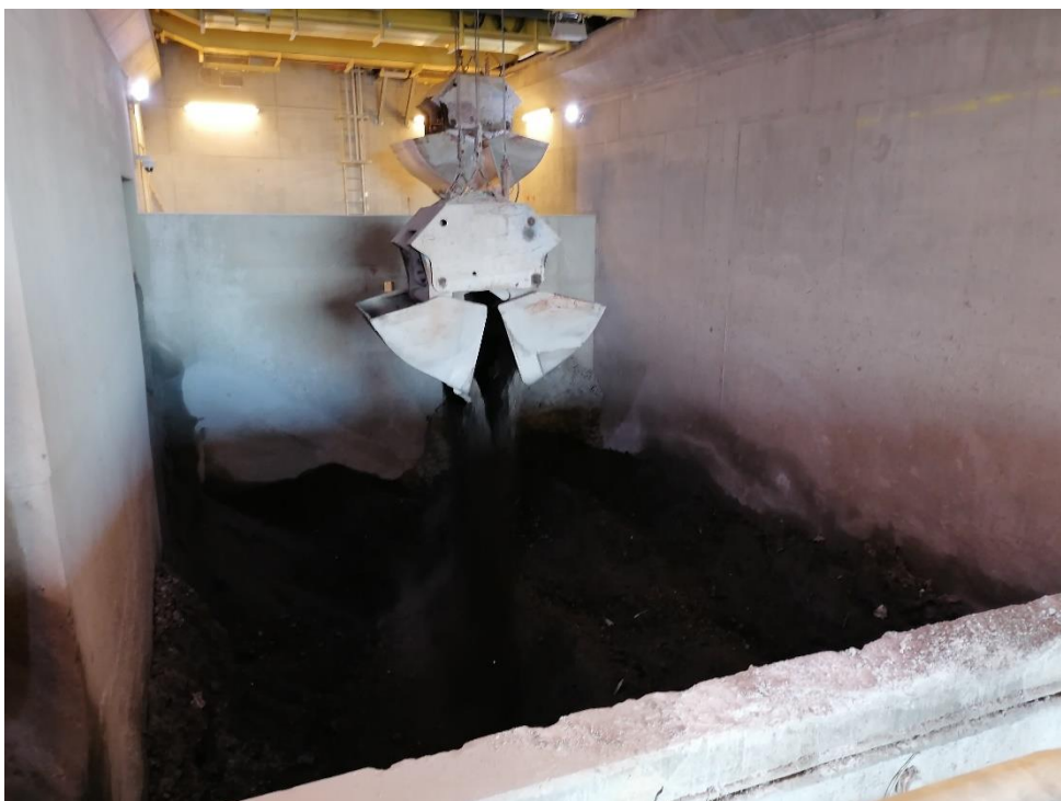
Slaggesilo for enden af port 10
