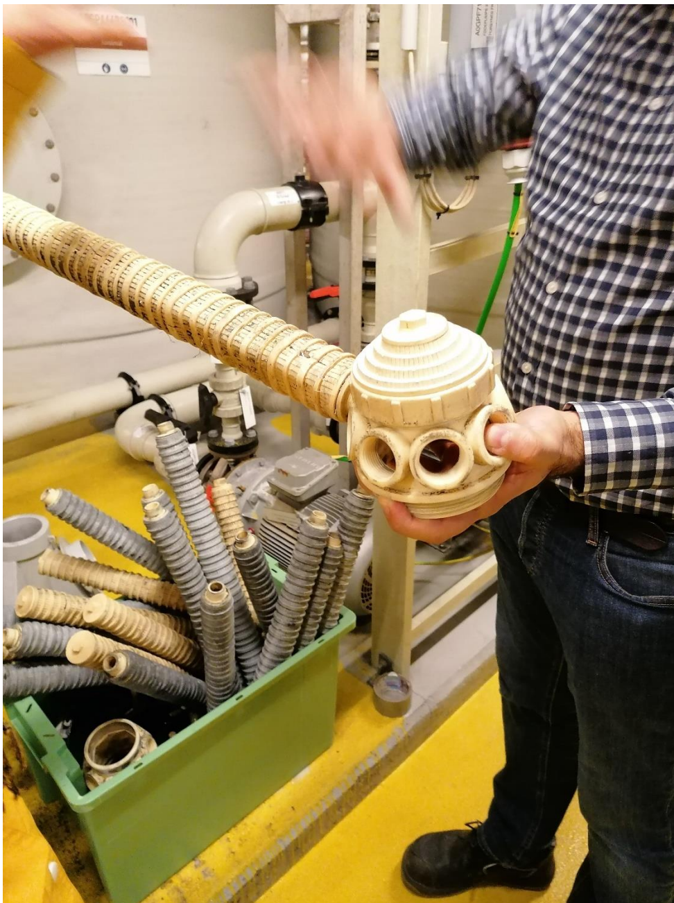
Defekte drænrør udskiftes i kulfilter.
