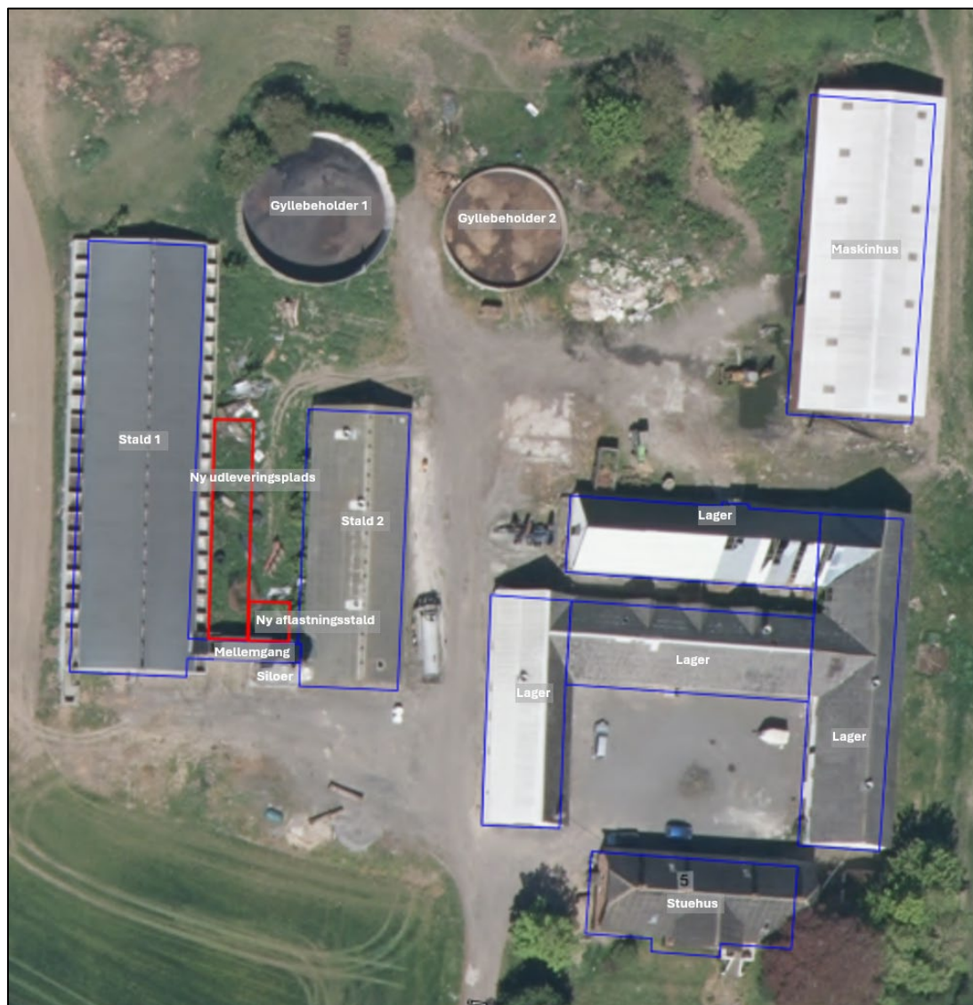
Figur 5. Anlægget på Dyndegård
