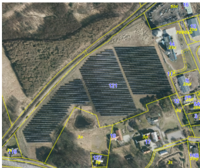
Figur 1 - Solvarmeanlæg ved miljøgodkendelse 16. november 2016.
