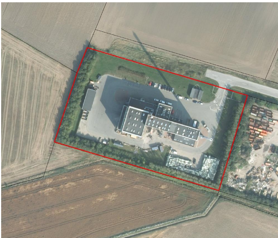
Luftfoto af Frederikshavn Affaldskraftvarmeværk, sommeren 2016.
