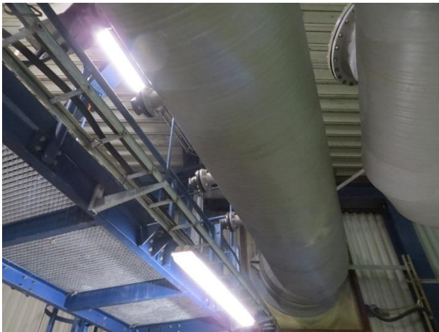
Målesteder i røggaskanalen umiddelbart inden skorsten
