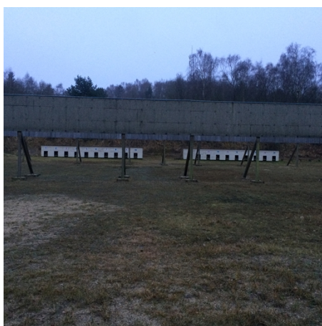
Foto fra tilsynet i 2019.
