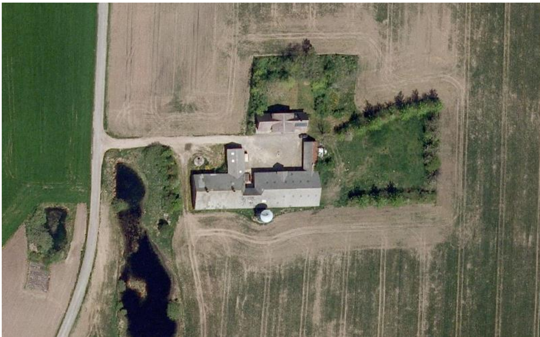
Ortofoto af Mølgårdvej 5 fra 2010. Beplantninger mod øst, nord og vest har afskærmet bygningsmassen.
