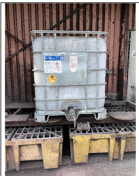
Kemikaliebeholder placeret mellem to spildebakker. Beholderen skal placeres korrekt.
