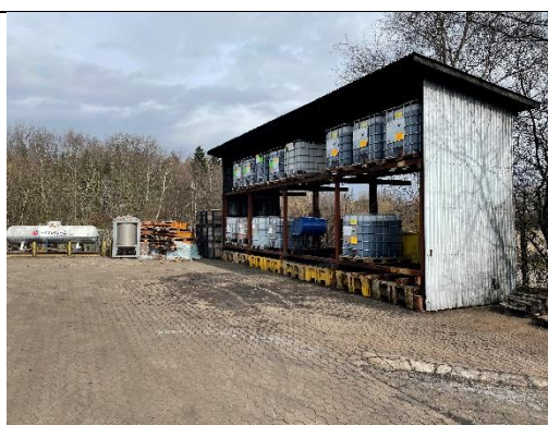
Oplag af kemikalier der anvendes i produktionen under halvtag og med spildbakker.
