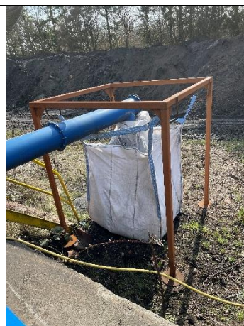
Metalstøv fra filtrerne opsamles i sække
