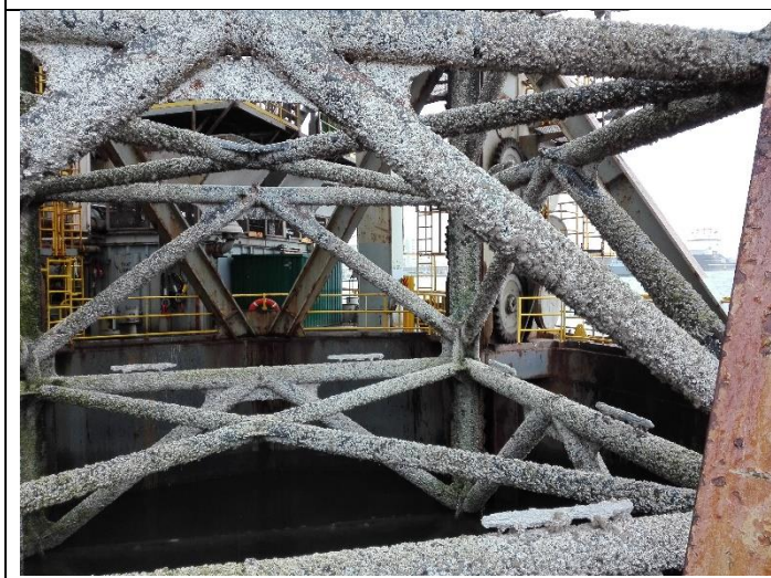
Et af boreriggens 3 ben. Gitterkonstruktionen er belagt med ruer
