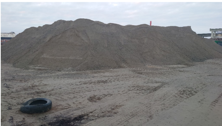
Oplag af ca. 3000 tons knust beton
