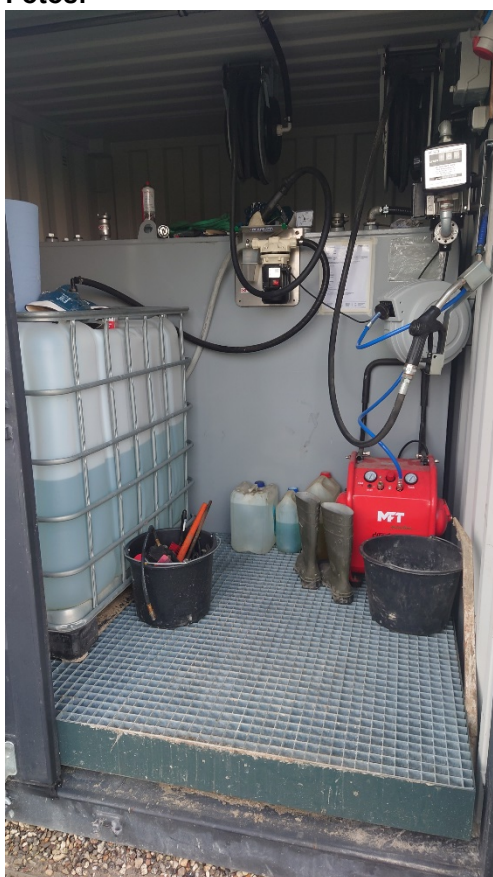
Container til olie og diesel med opsamlingsrist til eventuelt spild.
