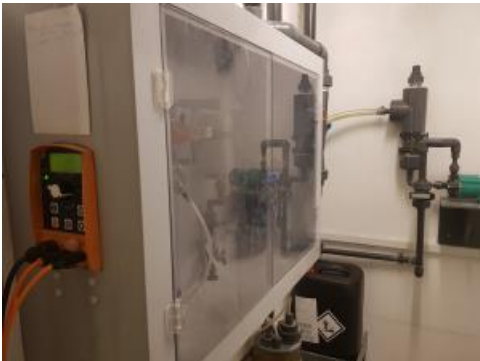
Chlor dosering med dagtank.
