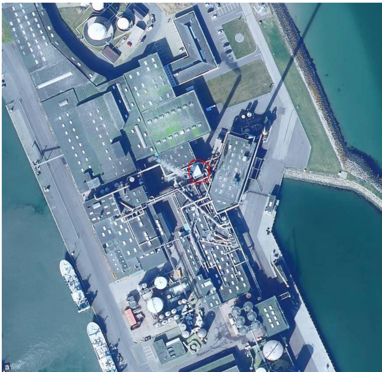
Figur 1: Det nye anlæg vil blive placeret hvor det gamle kalkanlæg stod, markeret med rød cirkel. Anlægget vil blive tilkoblet den eksisterende skorsten til venstre for den røde cirkel. Anlægget behandler rumluft, der ledes via eksisterende rørkanaler på taget fra 17 sugesteder (de hvide firkanter på taget).
