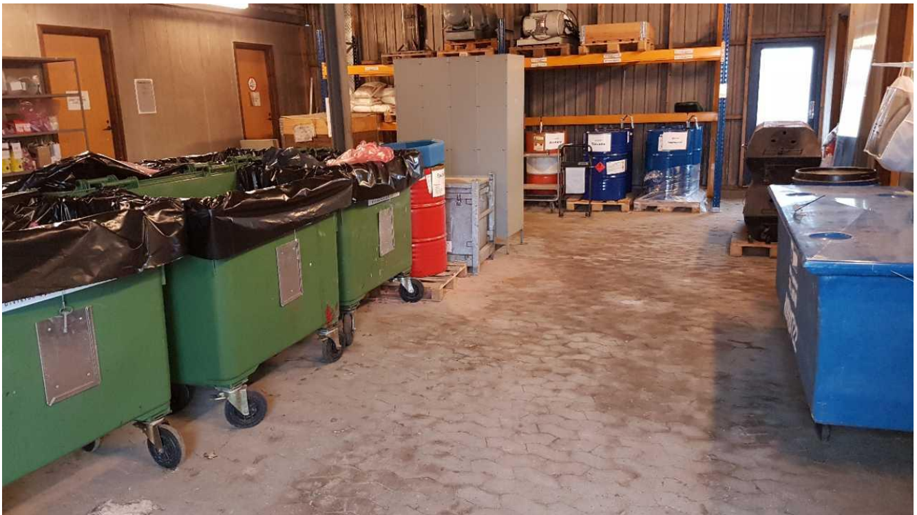
Kemikaliegården er overdækket og belagt med sf-sten med en membran under. Belægningen går op ved vægge og porte, således at belægningen fungerer som en spildbakke.
