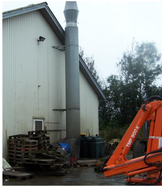
Spildolietank uden tag i 2011 - nederst til højre
