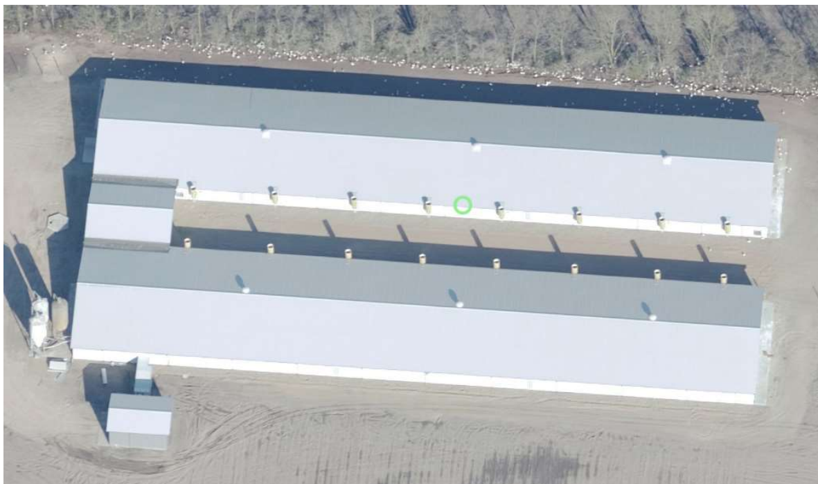
Stald 3 med servicebygning mod nord og gødningslæssehus mod vest.
