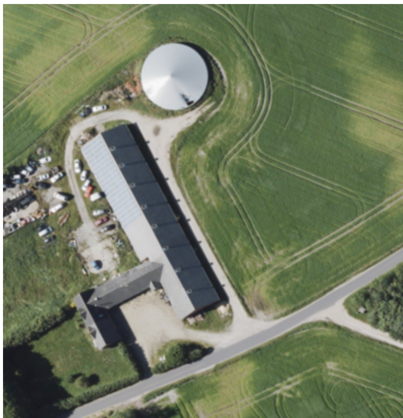
Østergårdevej 12B, 6880 Tarm: Indkørselsvej til gylletank
