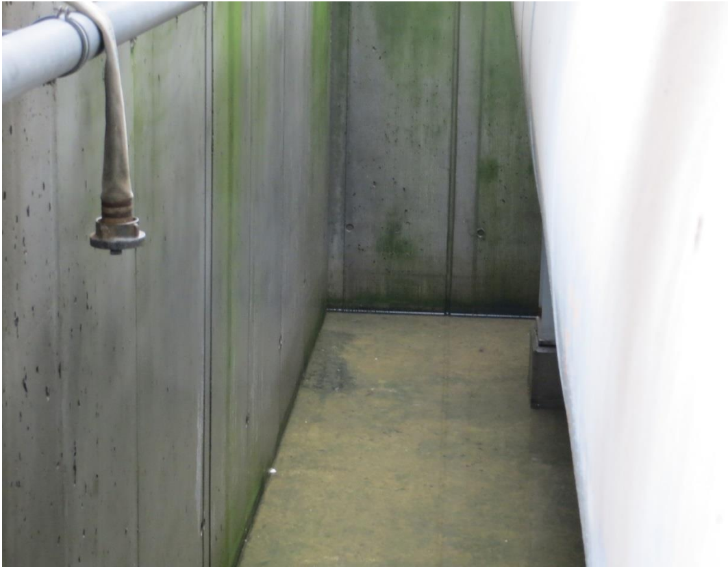
Bund i tankgård
