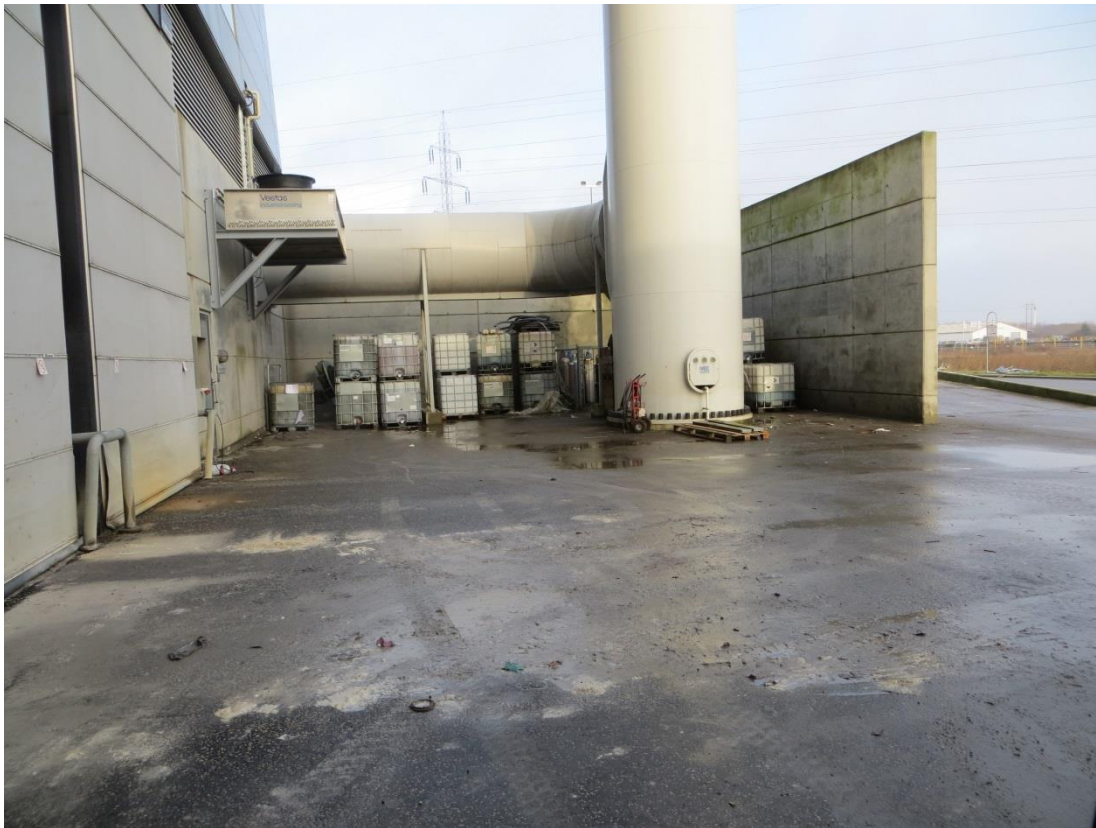
Asfalt udenfor udlevering af filterkage nærmest og ristegennemfald. Oplag af kemikalier bagerst. Pladsen afvandes via olie- og benzinudskiller til det interne rensningsanlæg.
