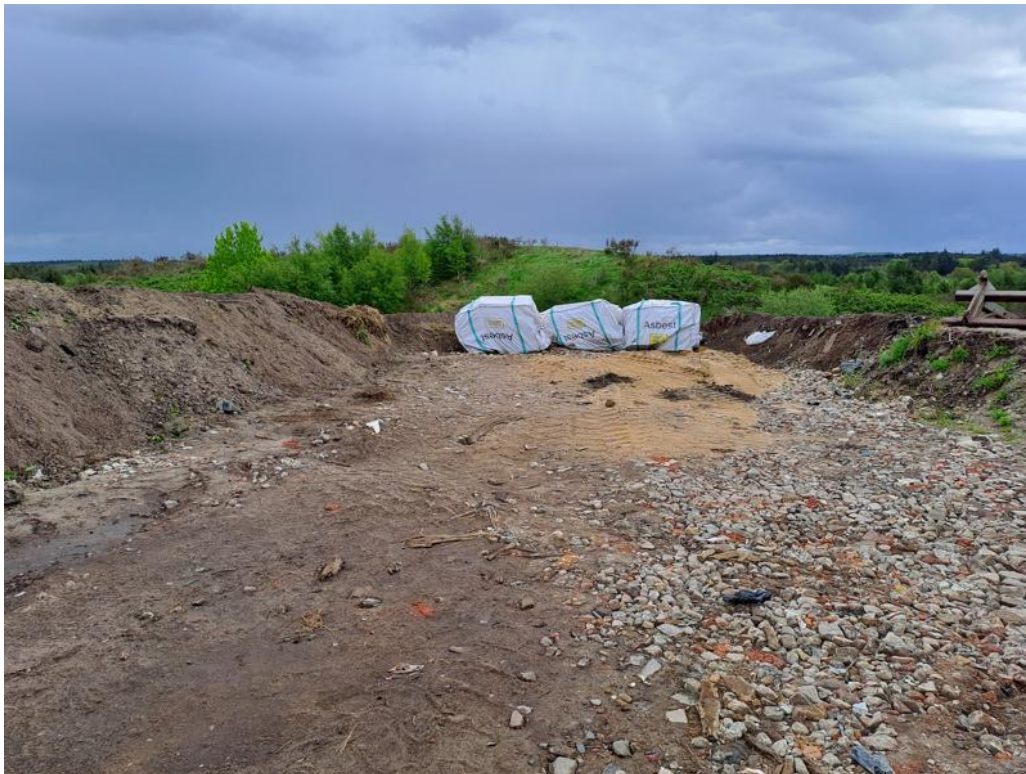
Billede 2. Tippen på celle 2.2.1. Der modtages kun indpakkede asbestholdig eternit på deponiet.
