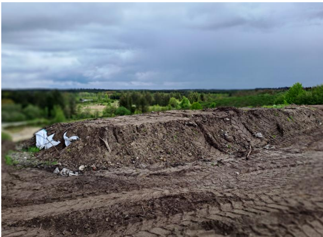
Billede 3. Der sker løbende afdækning af affaldet på depotet.
