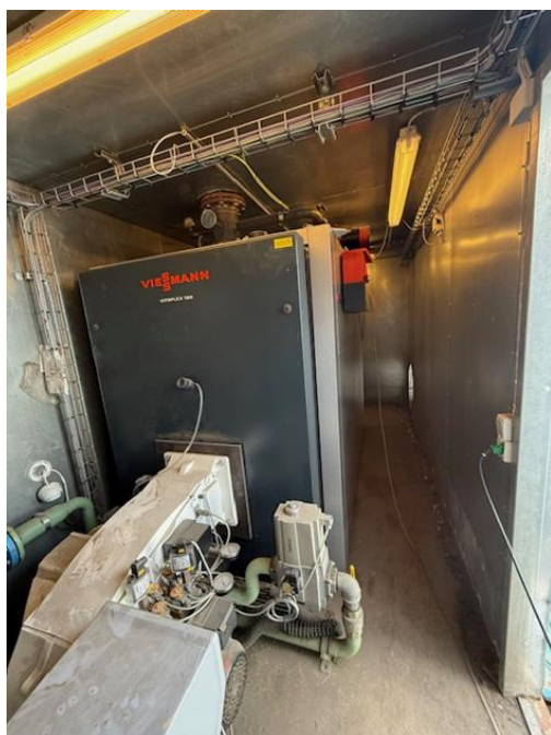
Figur 1 Gaskedel 2,89 MW.
