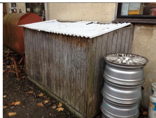
Foto 2 overdækning af kompressor
