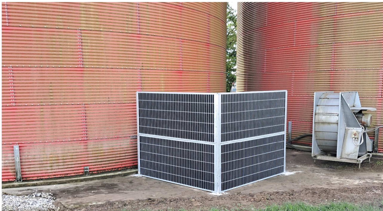
Støjdæmpende hegn omkring blæser ved silo 2. Bemærk blæser ved silo 1, som kun afskærmes ved brug
