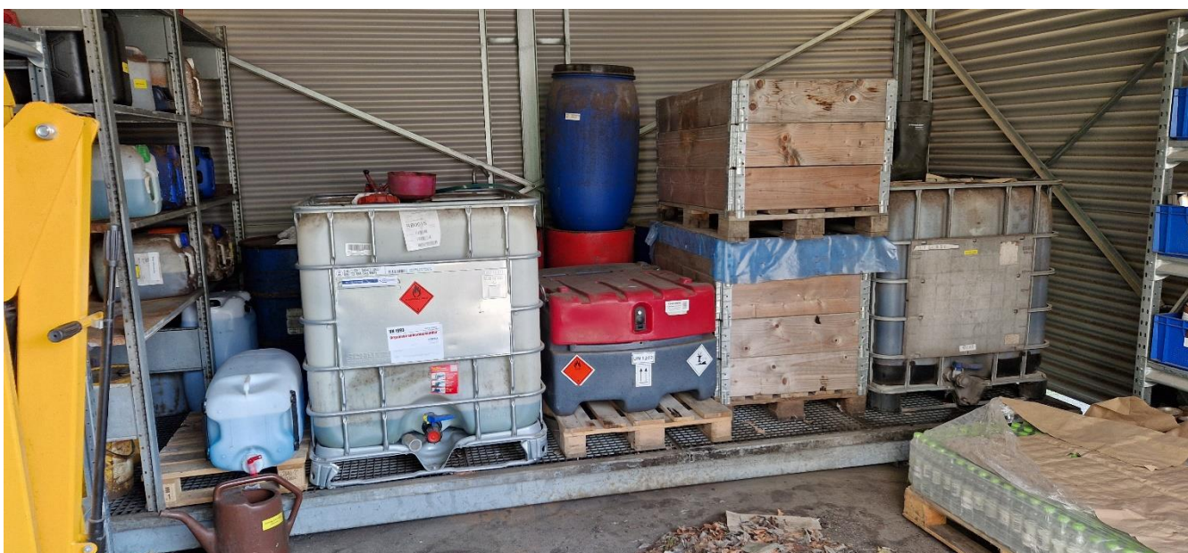
Oplag af terpentin affald i palletank samt diverse kemi-oplag med spildsikring.
