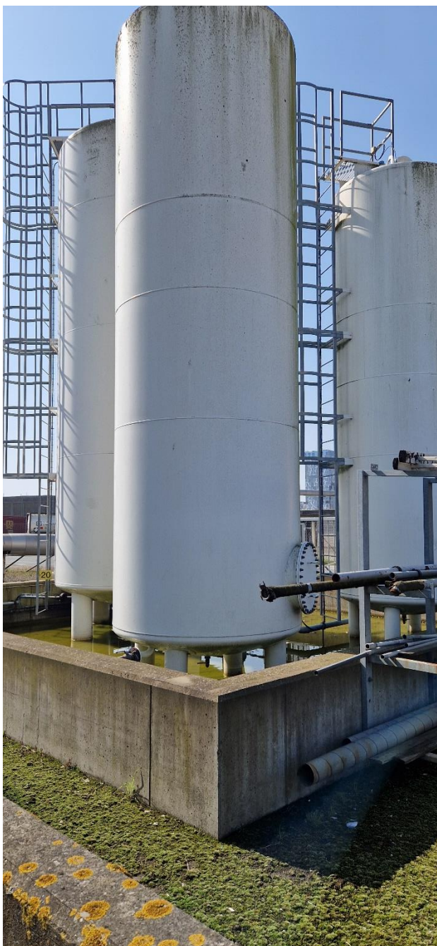
Lille tankgård med fast bund til tank til fyringsolie. De to øvrige tanke er tomme (tidligere terpentin-tanke).
