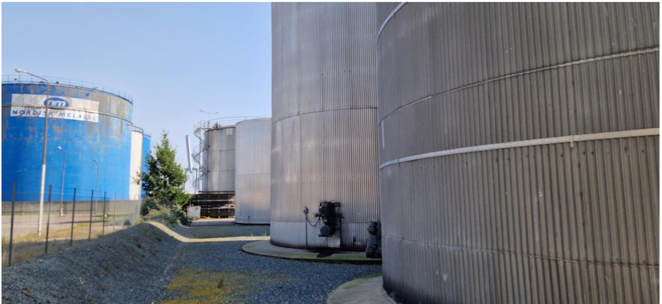
Tankgård uden fast bund med tanke til bitumen.
