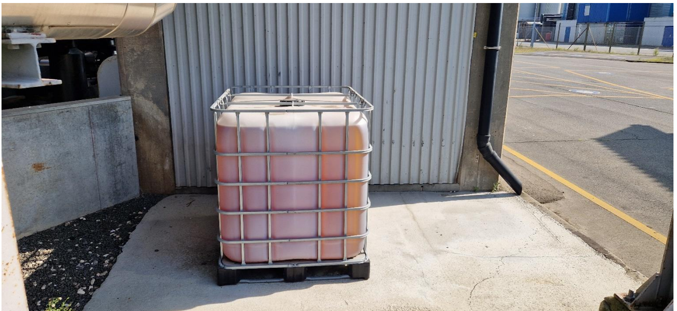
Oplag af hedolie i en 1000 liters palletank i nærhed af læsseramper, hvor der er afløb til regnvandssystemet.
