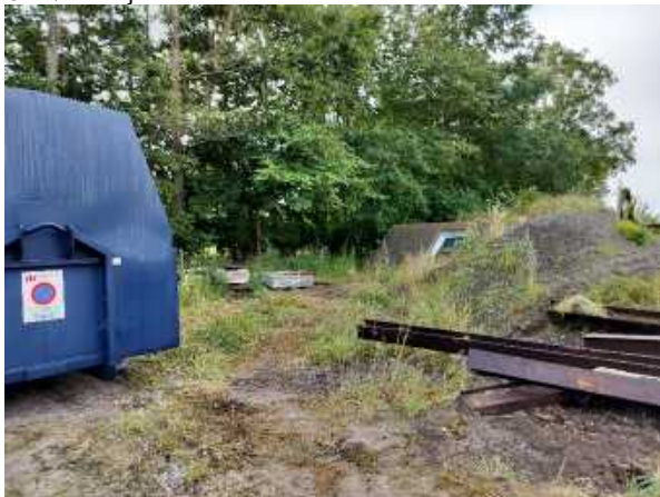
Container med isoleringsmateriale fjernet
