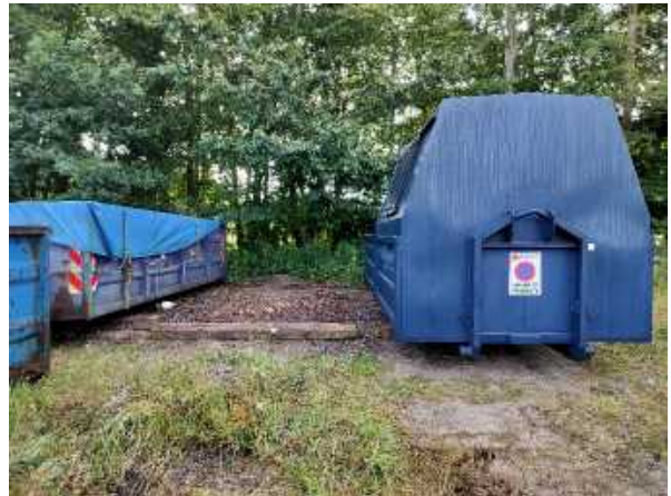
Container med isoleringsmateriale fjernet
