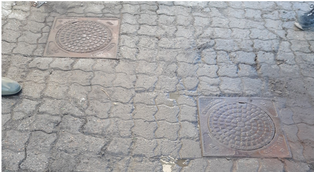
Figur 7. Grundvandsboring DGU 53.326 ud for aflæsser og omlastehal. Øverst: Dækslet over boring løftes. Der er påsat "pakning", men dækslet er ikke over DGU 53.326. Midterst: DGU 53.326 med løftet dækslet. Nederst: DGU 53.320 øverst i billedet, DGU 53.326 nederst i billedet.
