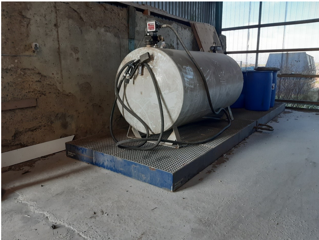
Figur 6. Dieselolietank.
