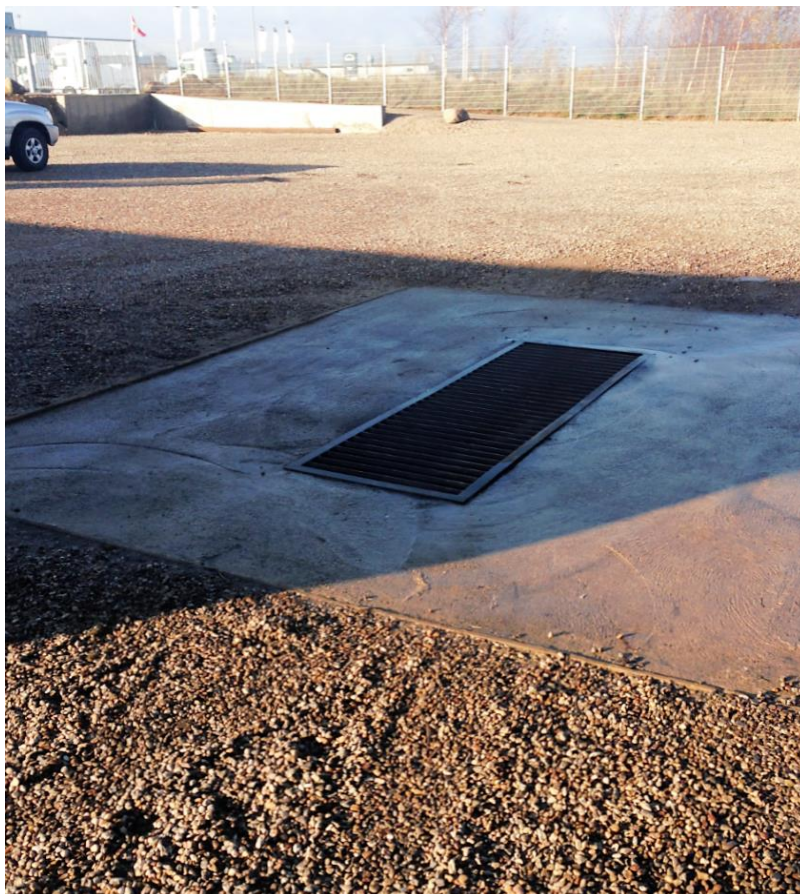
Nyetableret vaskeplads med betonbelægning og afløbsrist
