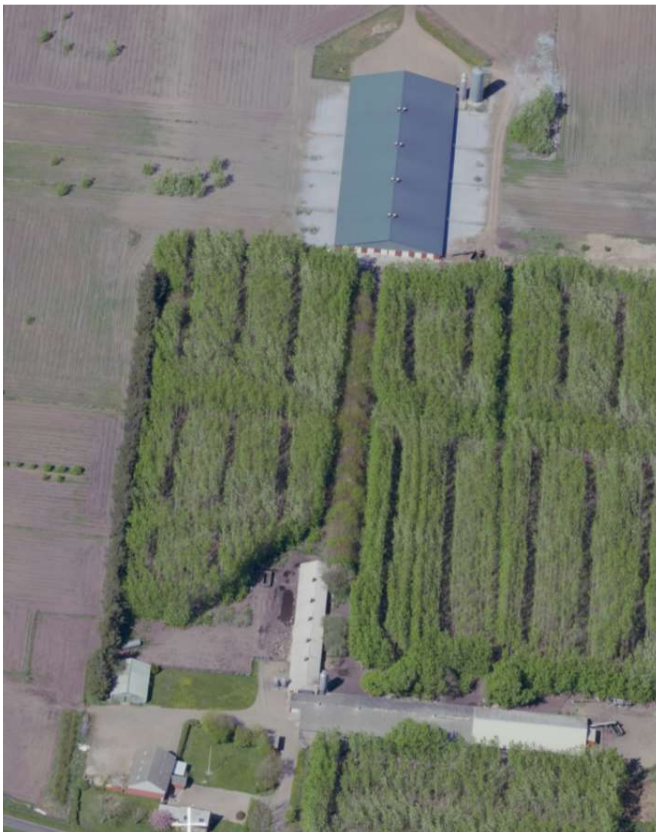
Figur 2 Stalde mm. som etableret og i drift – container, samletank og fodersiloer.
