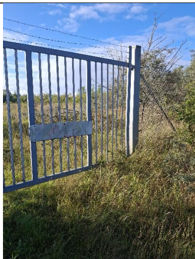
Stor port der er eneste indgang til deponiet – denne var aflåst med hængelås.
