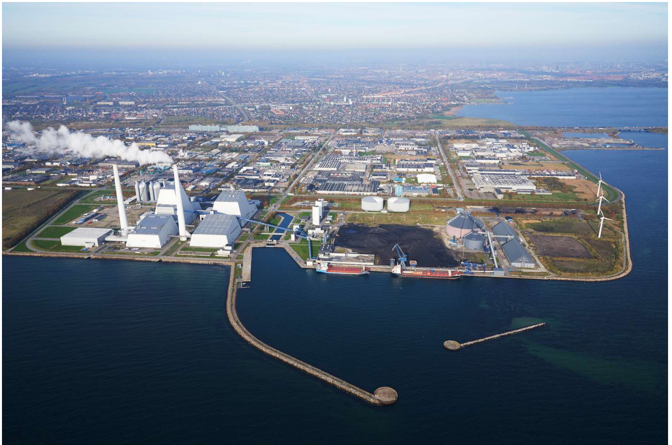
Billede: Oversigt Avedøreværket. Dronefoto taget fra syd mod nord. Billedet er taget forud for etablering af CO 2 fangstanlæg, nedbringelse af kul lager, fjernelse af fuelolietank og tilhørende installationer til fuelolie.
