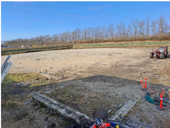
Billede: På areal hvor fuelolietank er fjernet er anlægsarbejde i gang til etablering af BESS batteri anlæg, som miljøgodkendt den 21. januar 2026.
