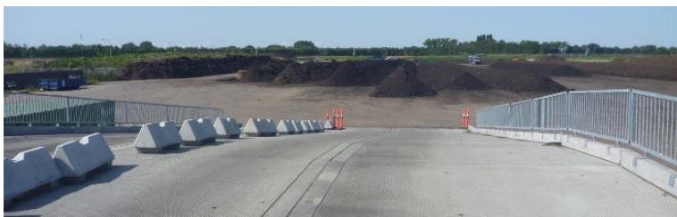
Figur 6: Slamkomposteringsanlægget set fra toppen af omlastningsrampen
