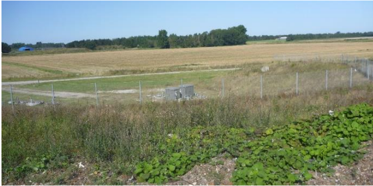
Figur 3: Vest for enhed 8A er etableret to pumpestationer. Den ene pumpe er slukket jf. ovenstående. Den anden pumpestation leder rent overfladevand/øvre sekundært grundvand fra under virksomheden ud i hovedkanalen, der afvander til Odense Kanal.
