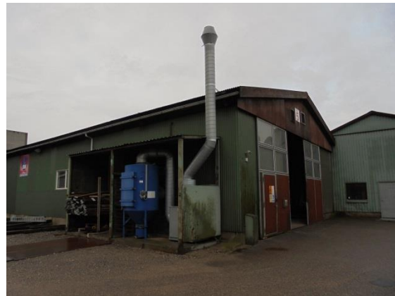
Punktudsugning og oprindelig udsugning fra Hal 2,3,4. Punktudsugning fra Hal 5
