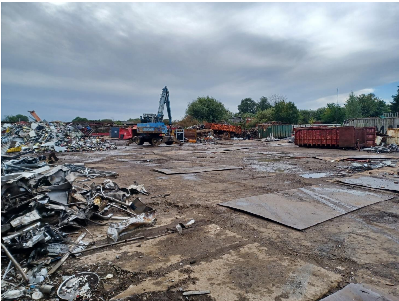
Billede 3. Huller i belægningen på virksomhedens areal er dækket med jernplader.
