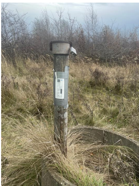
Boring AB, som er placeret i deponiet
