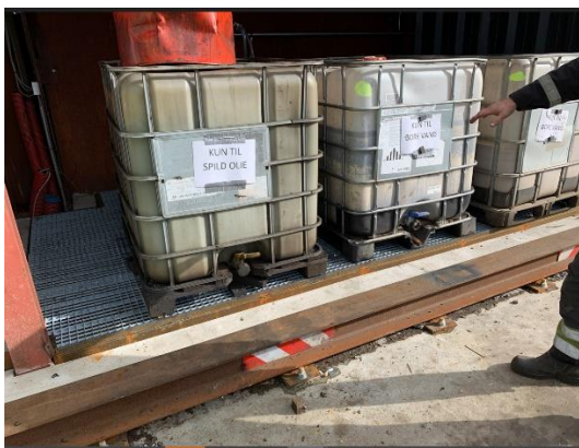
Foto af pallettanke på spildbakke
