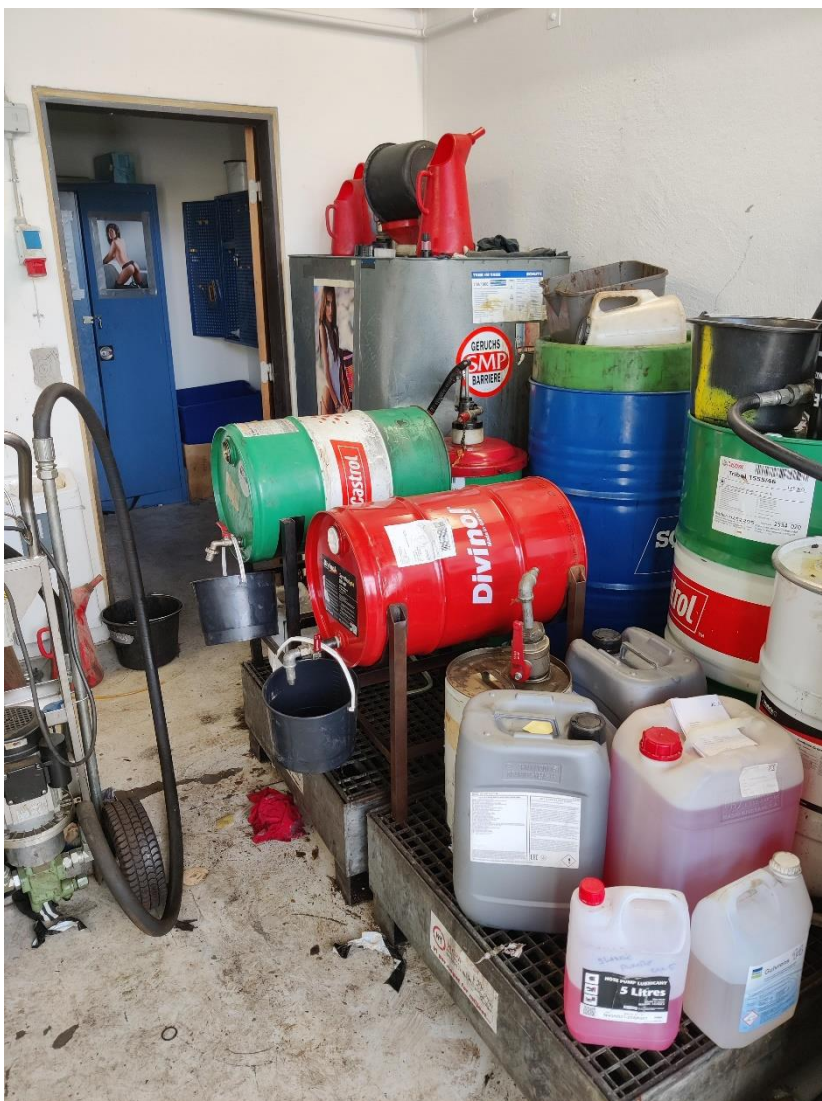
Olierum (Kun foto). Norfors oplyste at der er ikke er afløb fra rummet. Spildebakke kan rumme oplaget.
