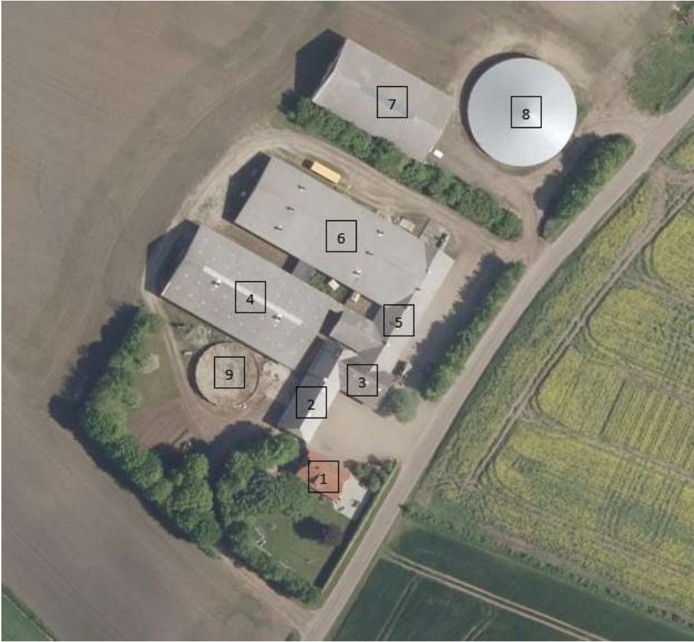
Figur 3. Oversigt over husdyrbrugets bygninger.
