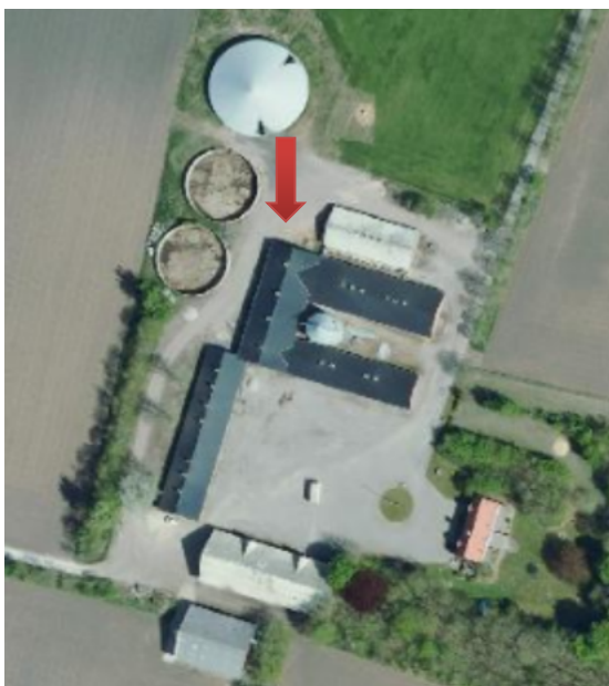
Figur 1: Ny opsamlingsstank, se under rød pil.
