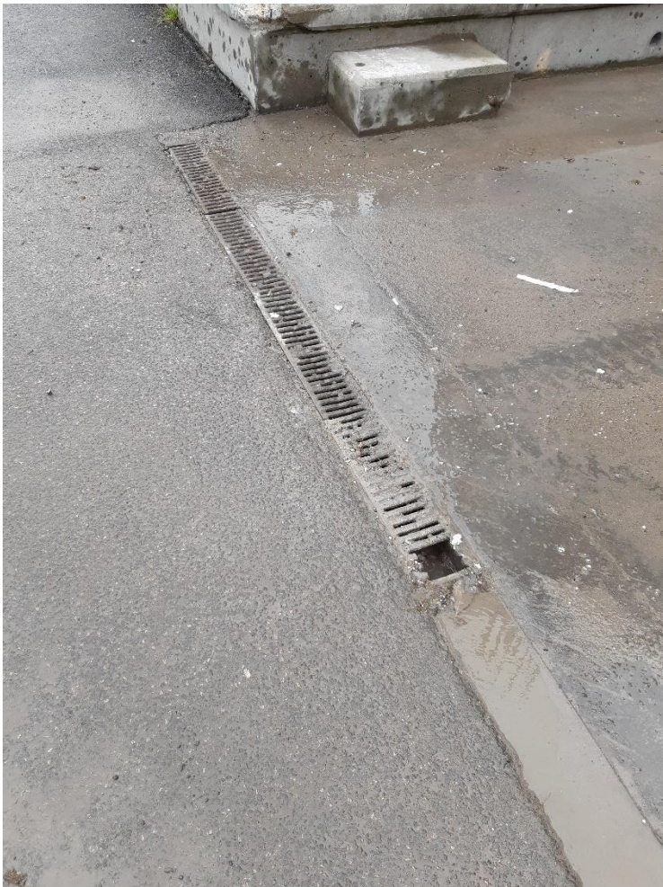
Afløb ved slaggegård
