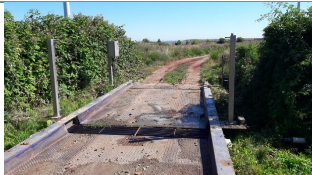
5. Automatisk vaskeplads ved indkørslen fra den NV-SØ gående vej for lastbiler.
