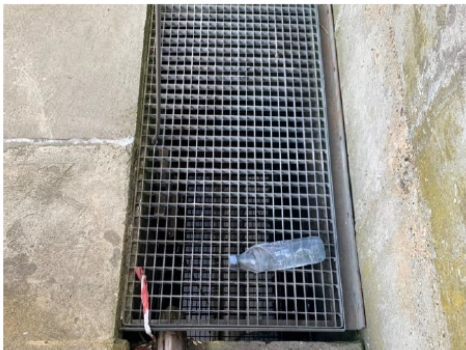
Figur 4: Foto af rist over opsamlingssumpen.
