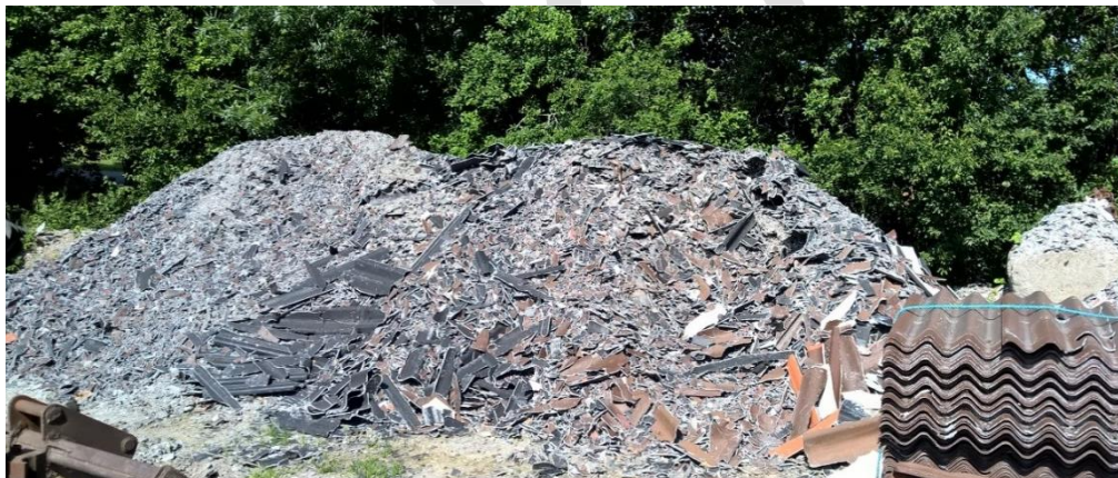
Knuste tagplader: sørg for dokumentation/analyse af, at tagpladerne ikke indeholder asbest! Foto: Aalborg
