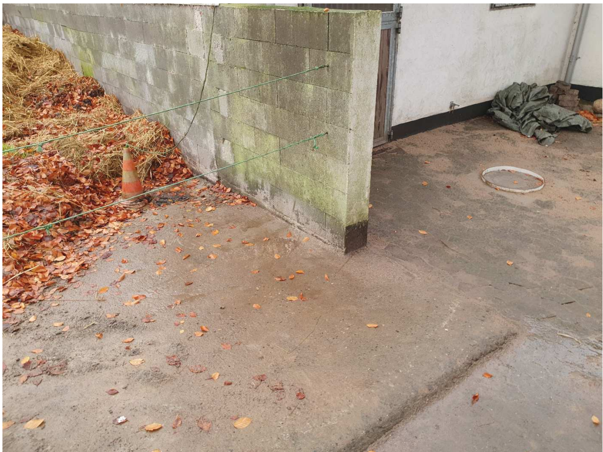
Afløb ved keglen, tank under brøndring.
