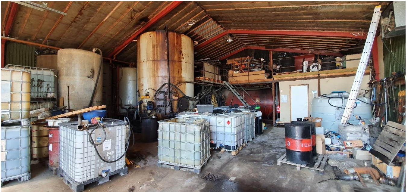
Tanke med olie, olieaffald og AdBlue står i hal 1, hvor sokkel er hævet og hvor der er tæt belægning uden afløb. Afløbsristen neders på billedet er udelukkende til en pumpeump uden afløb. Spild fra den største tank kan opsamles i hallen.
