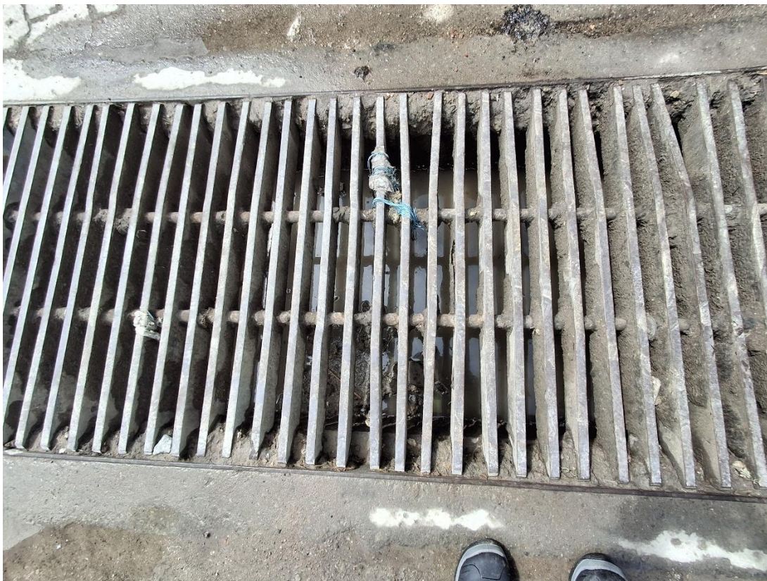
Figur 11. Sandfang i vaskepladsen udenfor værksted.
