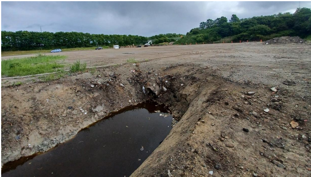
Figur 20. Perkolat i udgravning. Der ses afløb fra den tidligere affaldshåndteringsplads i den kommende enhed 3.
