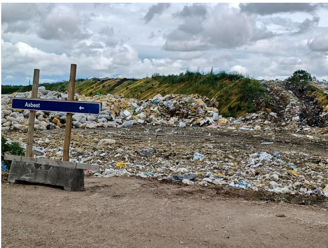
Figur 28. Affald opfyldt i V'et mellem enhederne 5 og 7. I baggrunden ses signalnet udlagt på enhed 5.
