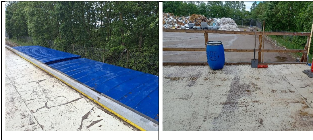
Figur 10. Omlasteanlæg til madaffald (rampen, containere, belægningen).
