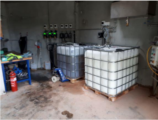
Kemikalietilsætning til drift af renseanlæg.
