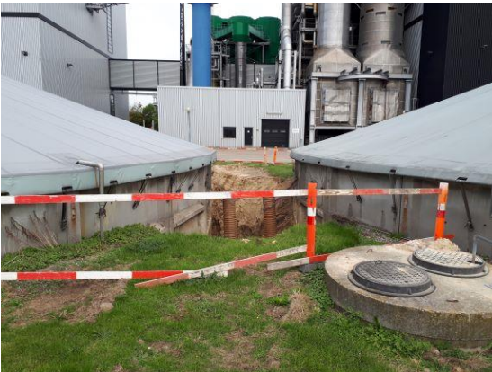
Utæt tank, som er under renovering.
