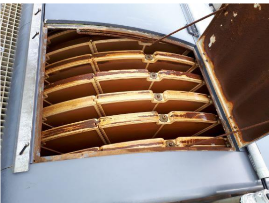
Mikrofiltrer til fjernelse af SS.
