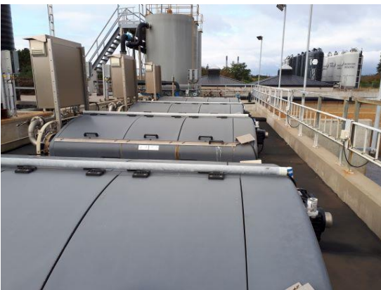
Mikrofiltrer til fjernelse af SS.
