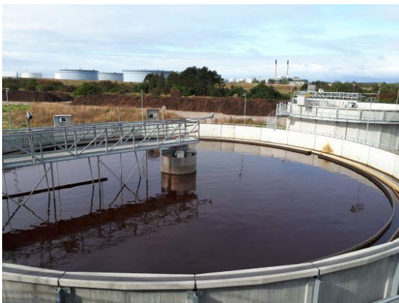
Efterklaringstank.
