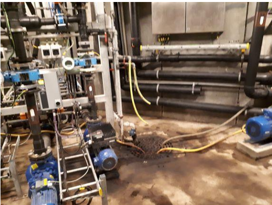
Slanger til udtagning af driftsprøver af affald.
