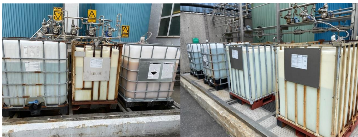
Figur 4. Brugssted for Spray 1-2 (t.v.) og tankgård med salpetersyre og natronlud til spray 3 (t.h.) Spray 4 forsynes via rørsystem direkte fra silotankene.
