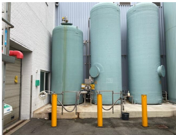
Figur 3. Silotankanlæg til salpetersyre og natronlud
