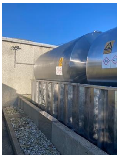
Figur 6. Opbevaring af svovlsyre og salpetersyre udendørs (t.v.) og glasfibertanke til PIX 113 (t.h.)
