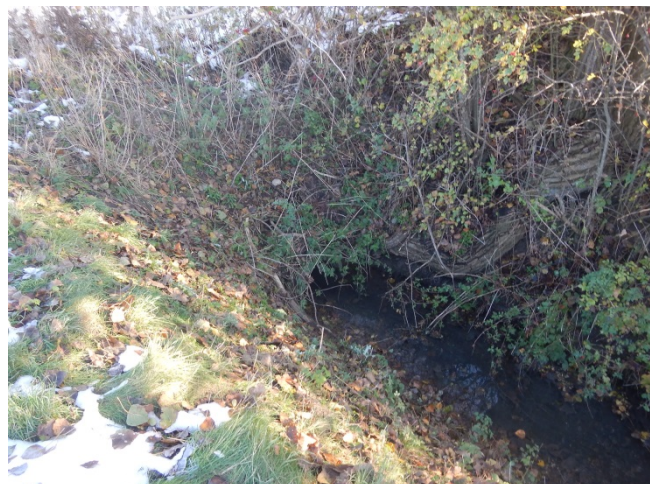
6. Start af frilagt vandløb (kommunevandløb nr 35.0 Højreby)
